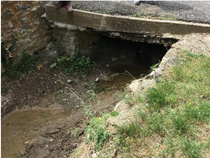
Passage ruisseau cimetière (avant)
